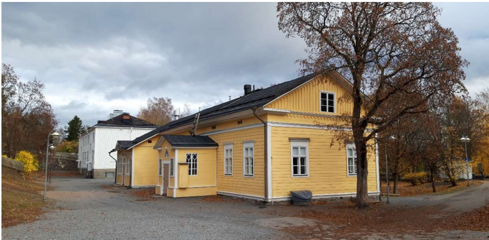
Kuva 1. Kansikuva Harjun koulun pihanäkymä. Etualalla B-rakennus ja taustalla valkoinen A-rakennus.
